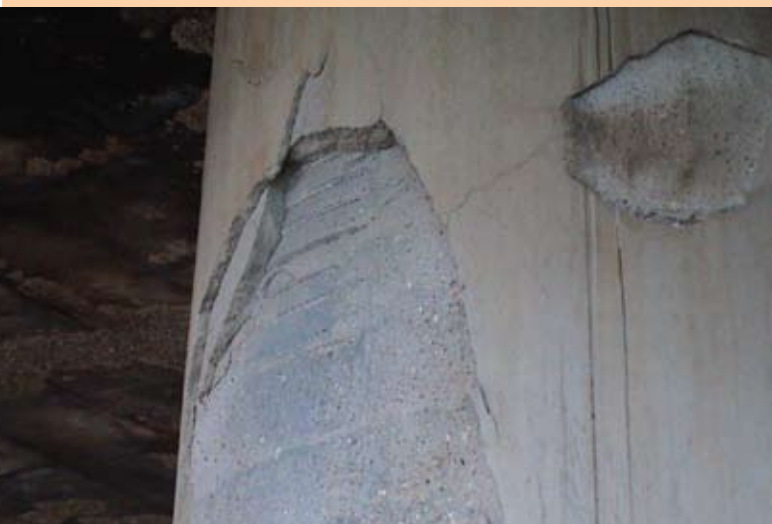
Kolomoppervlak na de brand RVS wapeningsnet Ø 2 - 50
