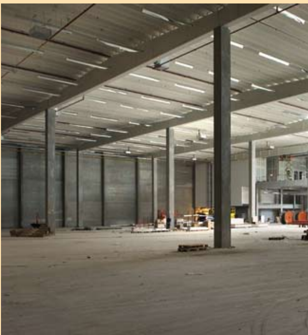
Foto onder: draagconstructieprincipe met betonnen kolommen en balken
