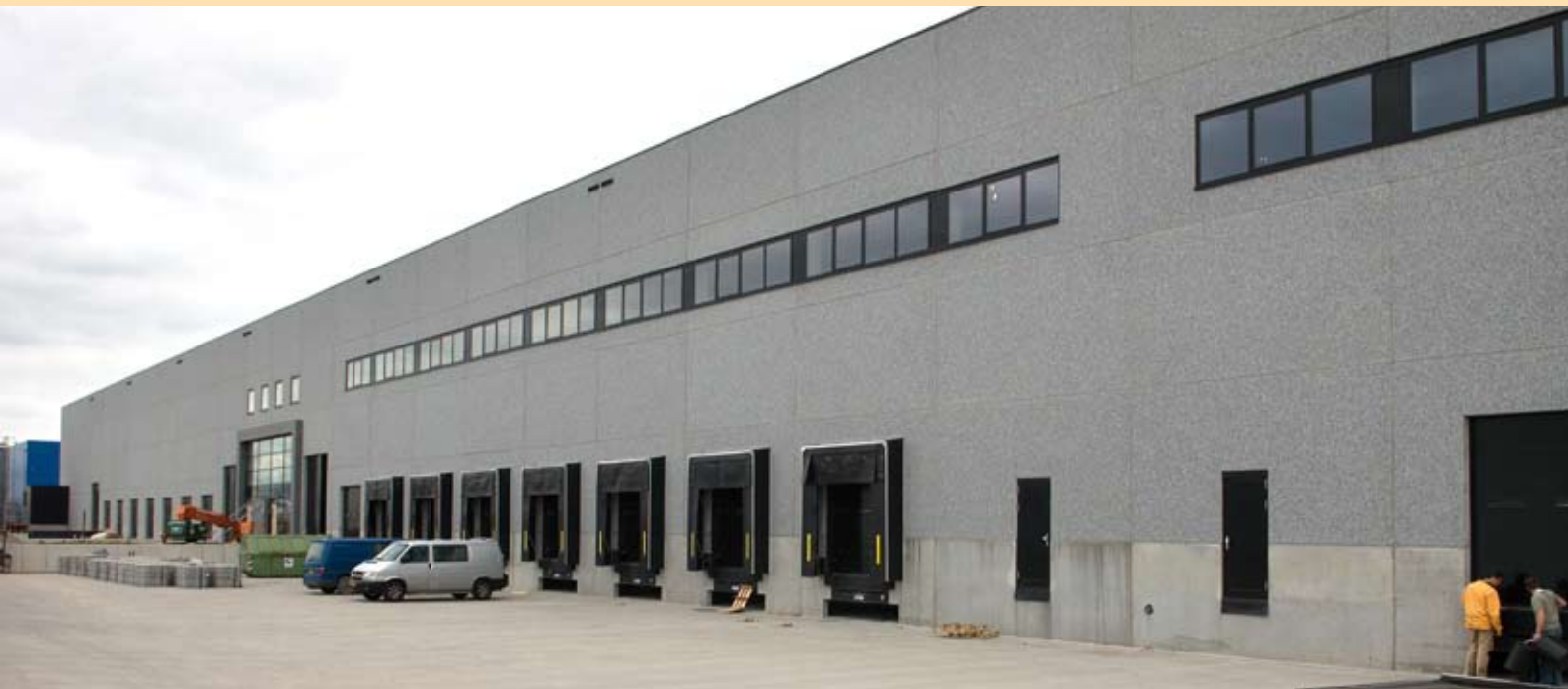
Foto boven: betonnen gevel opslaghal VAT Logistics (foto's: Concrex bedrijfsbouw)
