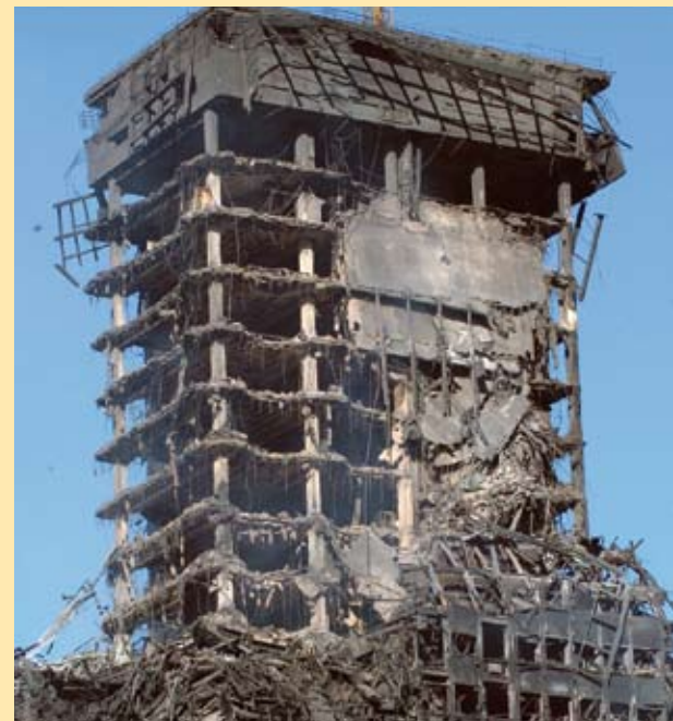
De brand verwoestte de onbehandelde stalen gevelconstructie boven de technische ruimte op de 16e verdieping totaal (foto's: IECA)
