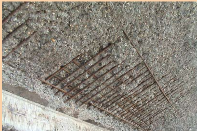
Aangetaste betonhuid verwijderd met gritstralen Viaduct na afronding reparatiewerkzaamheden (foto's: Walter Zwart)
