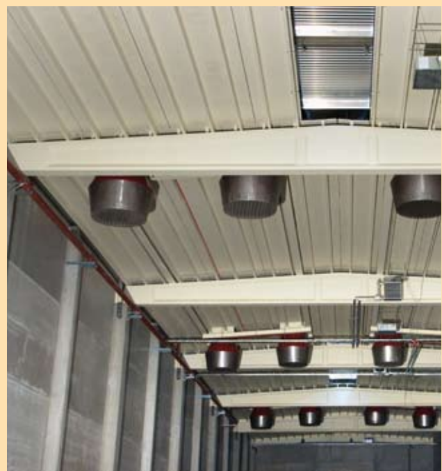
Schuimblussysteem in opslagruimte gevaarlijke stoffen
