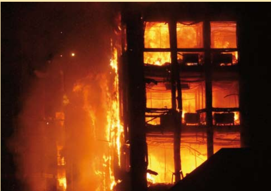
De brand verwoestte de onbehandelde stalen gevelconstructie boven de technische ruimte op de 16e verdieping totaal (foto's: IECA)
